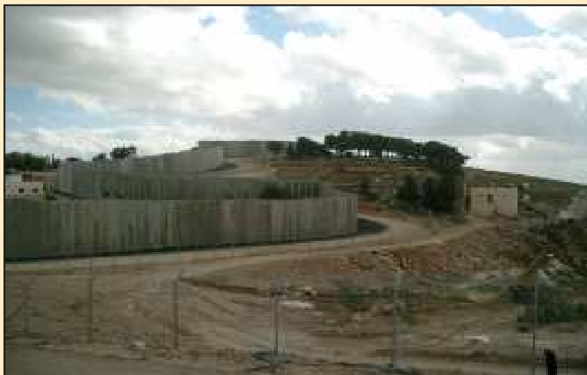
Barrera de seguretat a Cisjordània construïda amb blocs de formigó.
