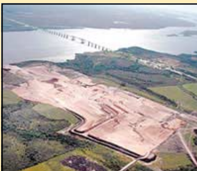
Preparació del terreny pel començament de les obres.
